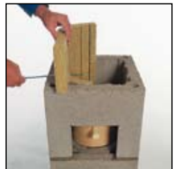
2.4 Włożyć połowę wełny mineralnej i dociąć na wysokość pustaka. Czynność powtórzyć z drugą połową wełny mineralnej.
