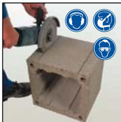
3.2 Za pomocą szlifierki kątowej wyciąć otwór w pustaku.
