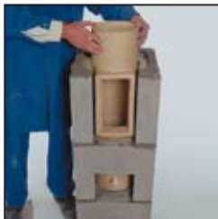
3.6 Trójkąt wyczystkowy osadzić w przygotowanym pustaku.
