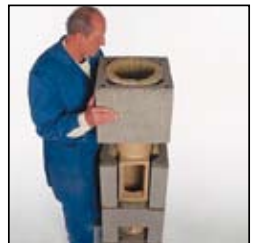
3.8 Osadzić na zaprawie pustak z wełną mineralną.
