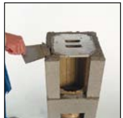
3.4 Nałożyć zaprawę montażową przy pomocy szablonu.
