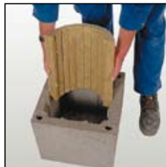
3.7 Wsunąć wełnę mineralną do kolejnego pustaka.
